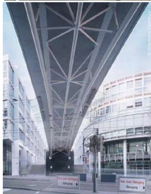
Voetgangersbrug Bayerstraße, München, DE (2005) Ackermann und Partner Architekten - Ackermann Ingenieure, München (DE) Bogen in buisprofiel S690 CHS 168,3 en 127,9 x 30 mm.
