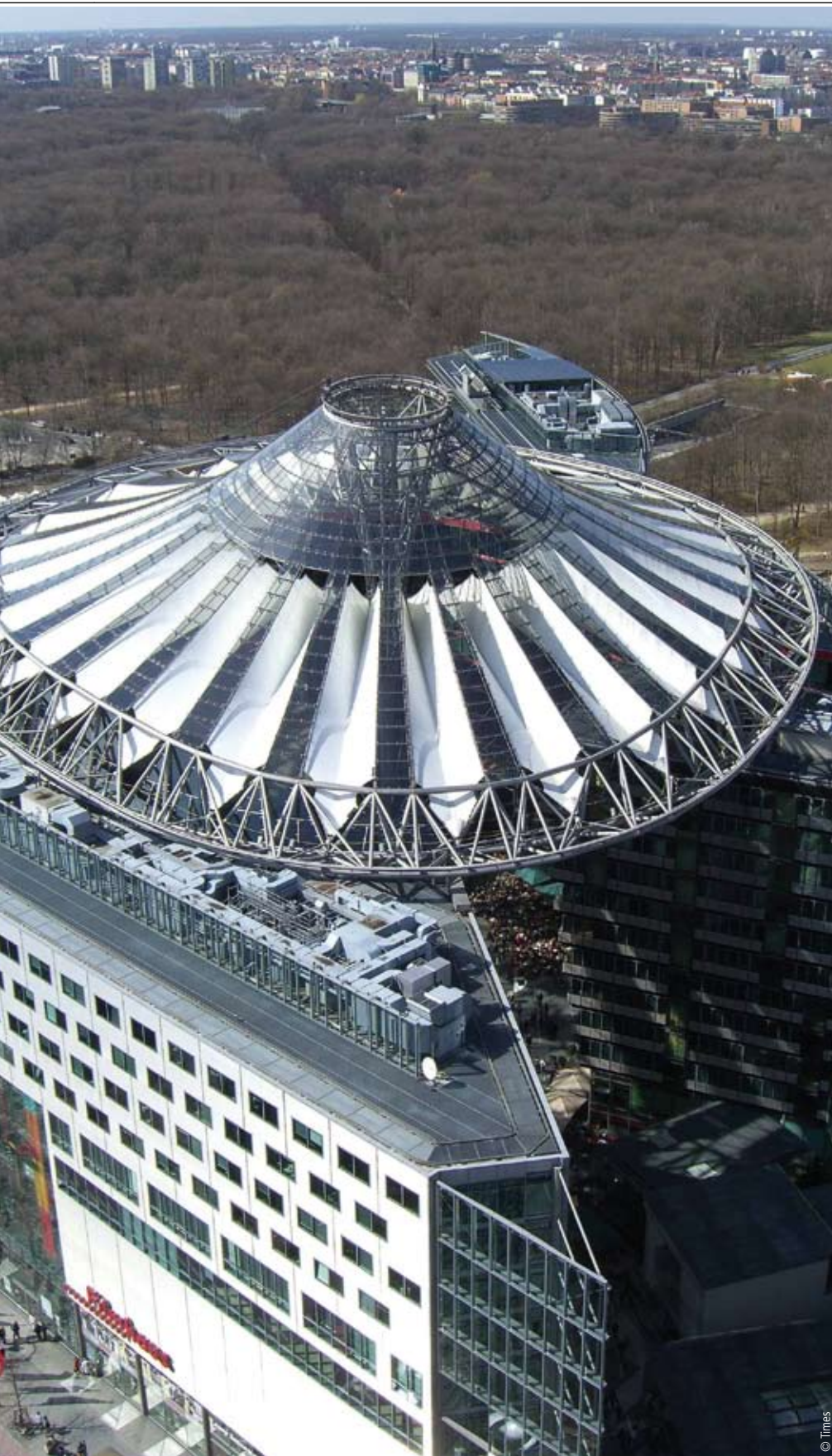
Forum Sony Center, Berlin, DE (2000) - Murphy/Jahn Architects, Chicago (US), Ove Arup & Partner, New York (US) Elliptische structuur (102 x 77 m), verankeringsplaten trekkers in S690 QL1 _Charpente elliptique (102 x 77 m) - ancrages des tirants en S690 QL1
