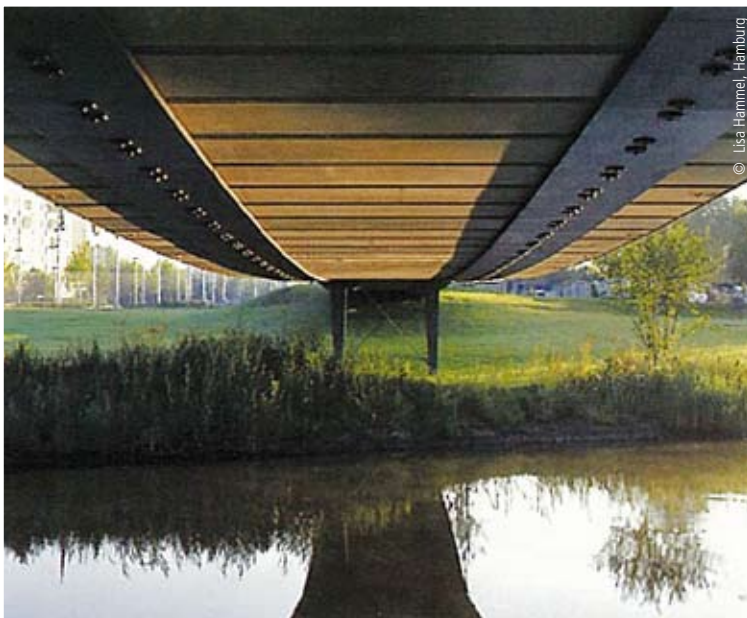
Nordbrücke IGA 2003, Rostock (2003) Schlaich Bergermann und Partner, Stuttgart Spanbanden 600x30 uit S690 QL1 _Bandes de traction 600x30 en S690 QL1
