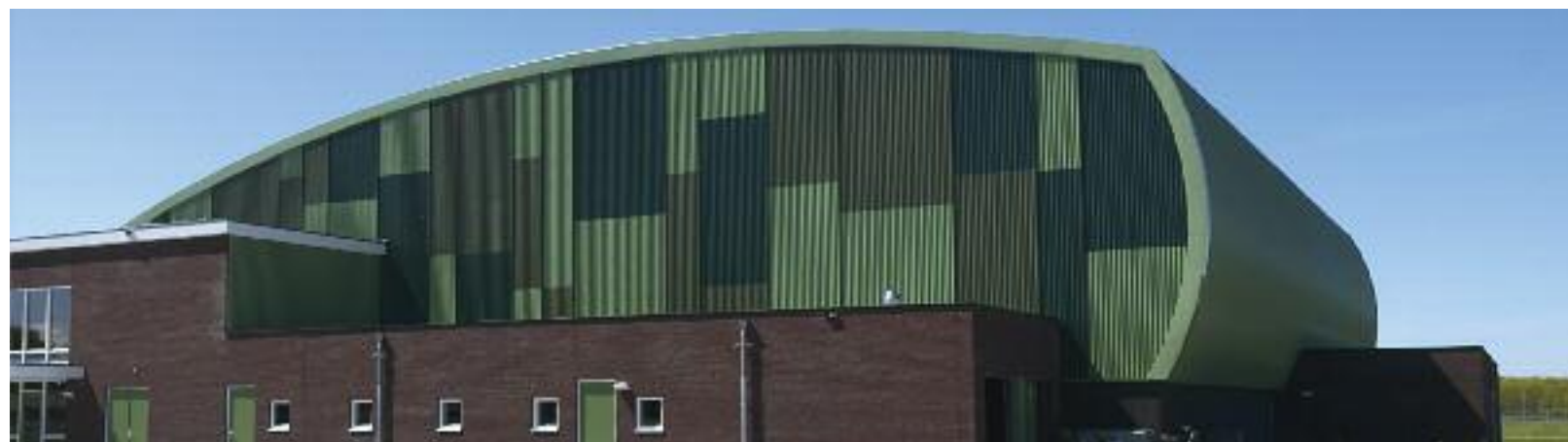
Project: Sportcomplex Nieuwehorne, Nederland Architect: Strategie Architecten Fotografie: © 2013 ArcelorMittal, alle rechten voorbehouden
