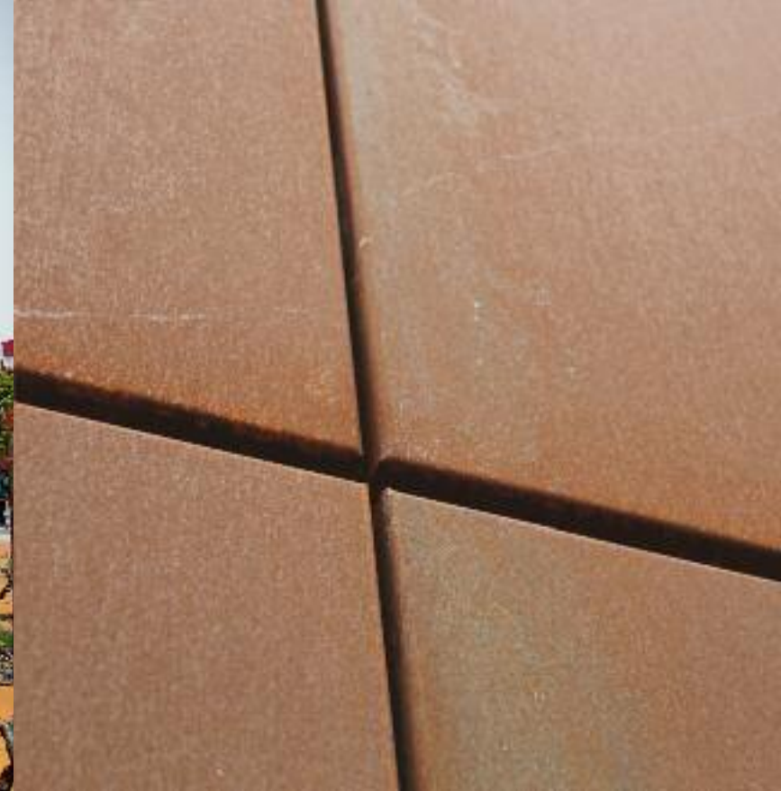
Metal Structures Centre (MSC) in het Technologiepark Zwijnaarde, België Architect: © Patrick Lefebure, Archipl Architecten Fotografie: © Roger Hubert, ArcelorMittal
