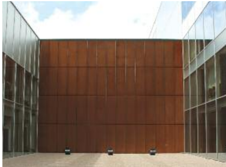
Project: Metal Structures Centre (MSC) in het Technologiepark Zwijnaarde, België Architect: © Patrick Lefebure, Archipl Architecten Fotografie: © Roger Hubert, ArcelorMittal
