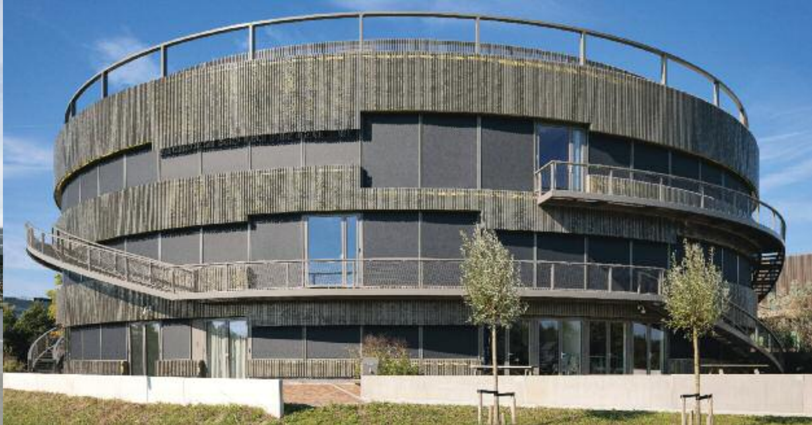
Project: Stoas Vilentum Hogeschool in Wageningen, Nederland Leverancier van het systeem: ZND Nedicom i.s.m. Jack Muller B.V. Architecten: © BDG Architecten Ingenieurs Zwolle Fotografie: © Dirk Verwoerd
