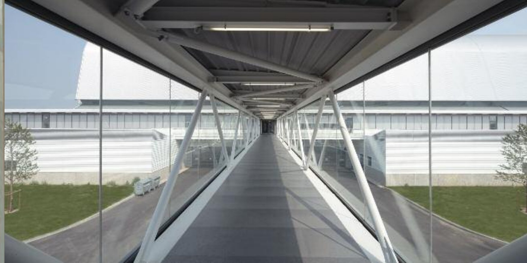
Project: onderhoudscentrum van Cargolux op de luchthaven van Luxemburg-Findel Architect: © Jean-Luc Dupanloup, projectleider, Jean-François Schmit Architectes Fotografie: © Gaston Bergeret
