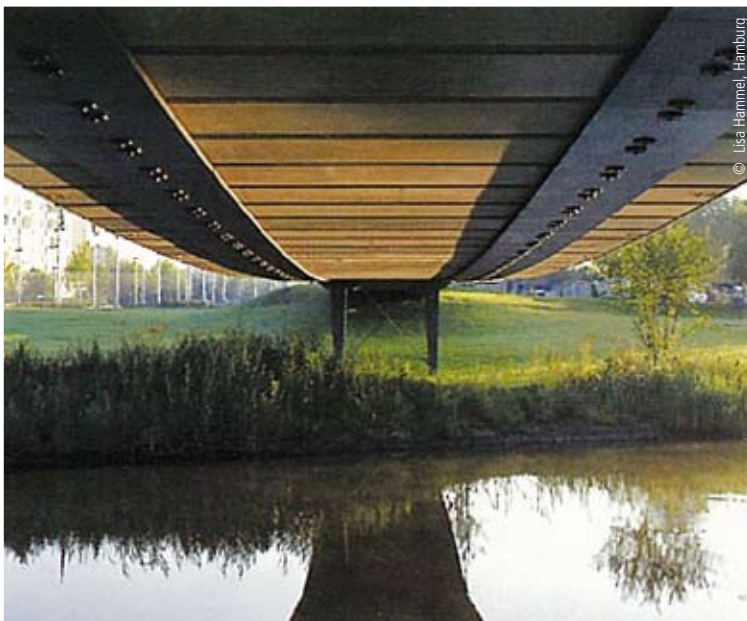
Nordbrücke IGA 2003, Rostock (2003) Schlaich Bergermann und Partner, Stuttgart Spanbanden 600x30 uit S690 QL1 _Bandes de traction 600x30 en S690 QL1
