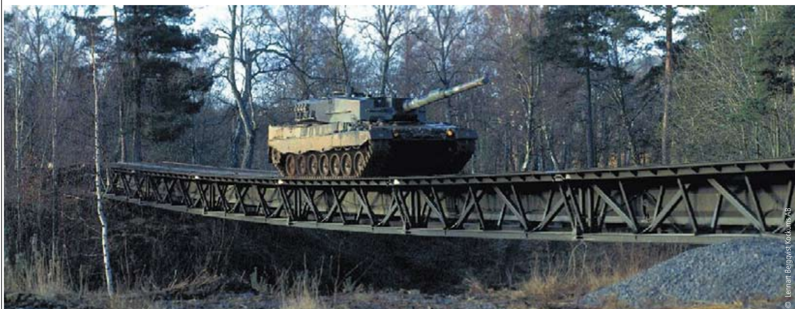
Voorlopige brug "Fast bridge 48" Nagenoeg alle staal is S1100
